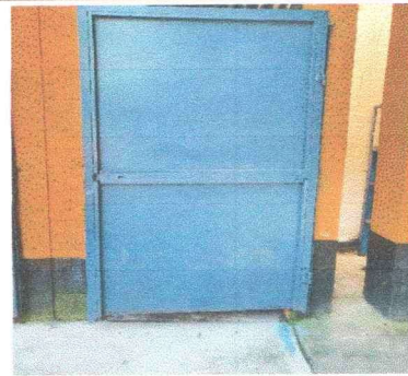
Foto 4: Sustrucion de puerta servicio Sanitario
