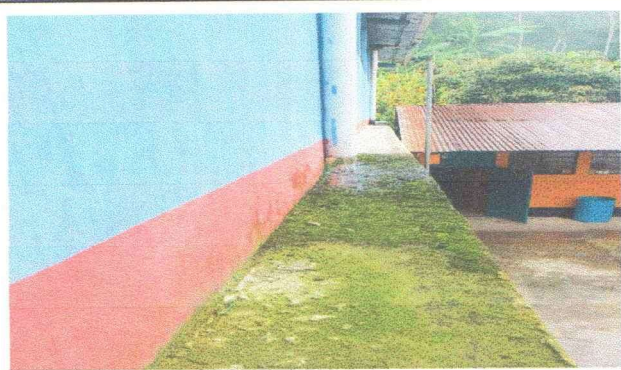
Foto 2: Reparacion de bajada de agua pluvial, tubo PVC 3"
