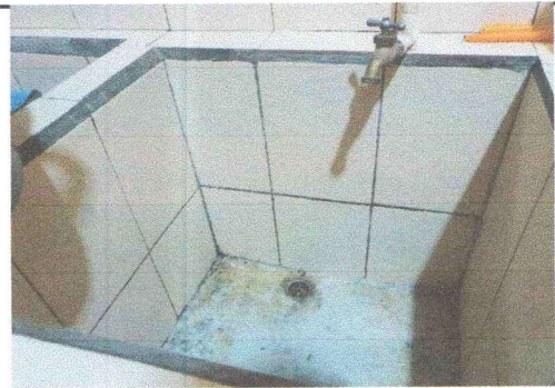
Foto 5: ustritucion de tuberia pvc linea principal aguas negras
