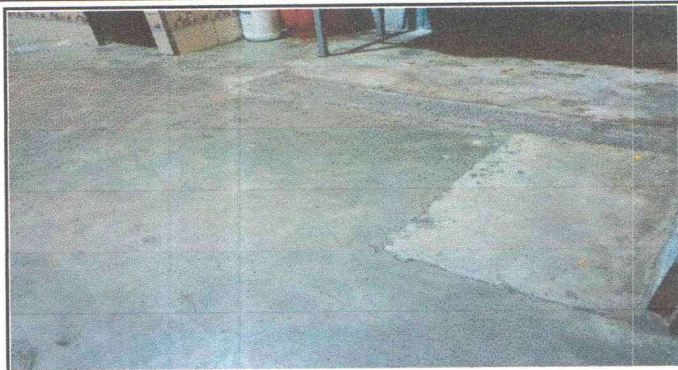
Foto 1: Sustrucion de piso ceramico
