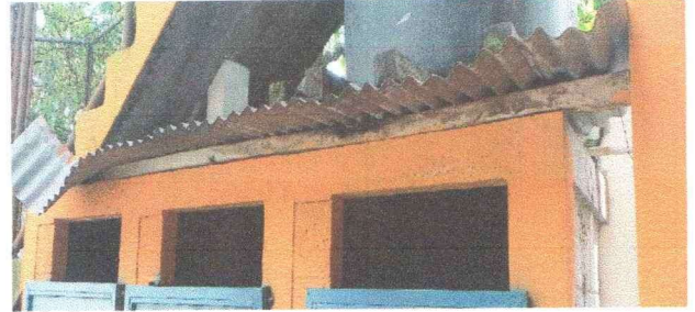
Foto 2: sustitucion de estructura de soporte de madera por metal
