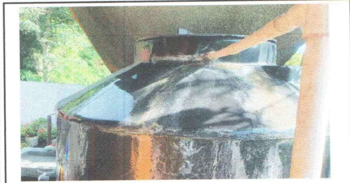
Foto 1: Sustitucion de deposito de agua 1000lts
