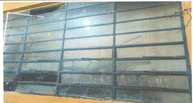
Foto 6: sustitucion de vidrios
