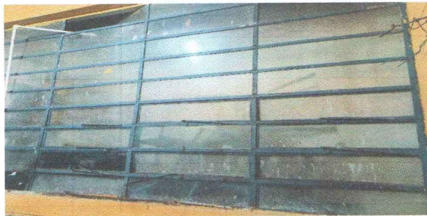
Foto 5: sustitucion de estructura de metal de ventana
