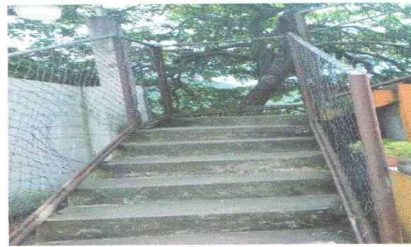
Foto 4: Suastitucion de baranda de metal S
