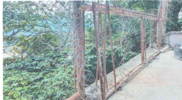
Foto 6: Reparacion de muros perimetrales de con tubo hg y malla galvanizada
